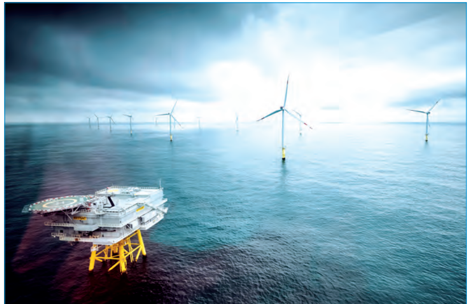
Blick aus einem Helikopter auf den Windpark Riffgat mit dem Umspannwerk im Vordergrund
