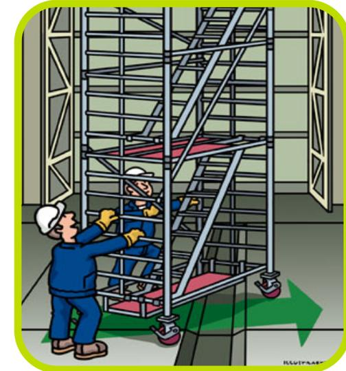
Fahrgerüste nur "über Eck" oder in Längsrichtung verfahren.
