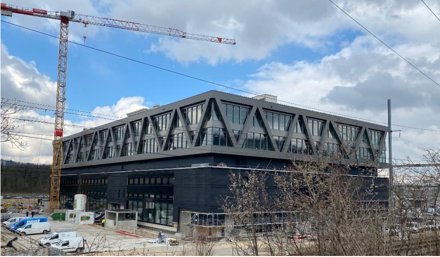
BU: Baufortschritt im uptownBasel (Bildquelle: uptownBasel)
